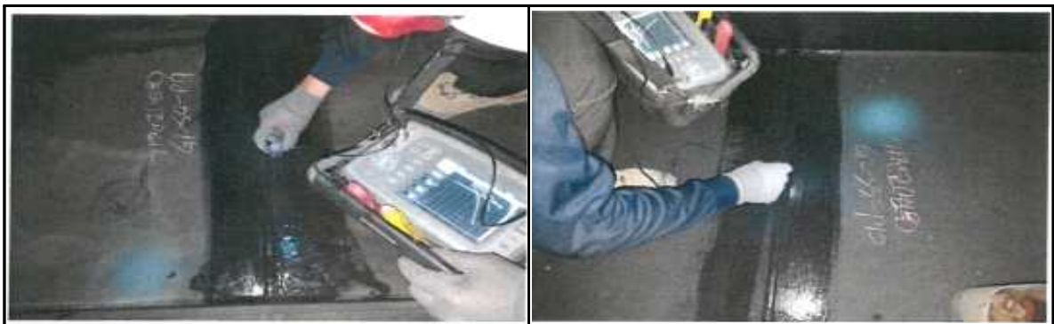
<사진 3.3.1> 맞대기용접부 결함조사(UT)
