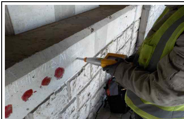
슈미트해머에 의한 반발경도 시험 (하부구조)
