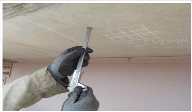
탄산화 시험(버니어캘리퍼스 측정)
