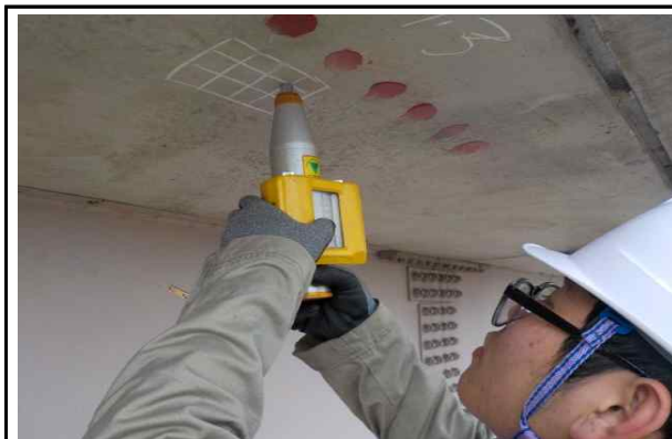
슈미트해머에 의한 반발경도 시험 (상부구조)
